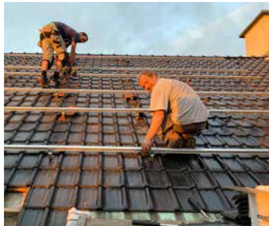
Die Installation unserer Photovoltaik-Anlage durch die Firma VerticalSolar im November 2020 © Andreas Krell
