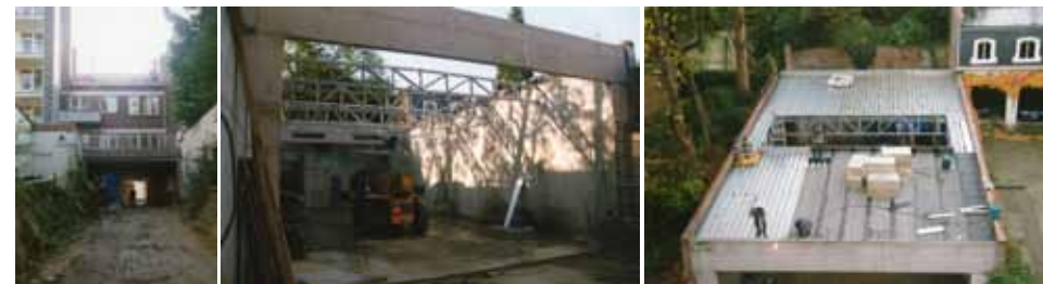
Der Bau von St. Paulus im Jahr 2000 © A. Hürfeld
